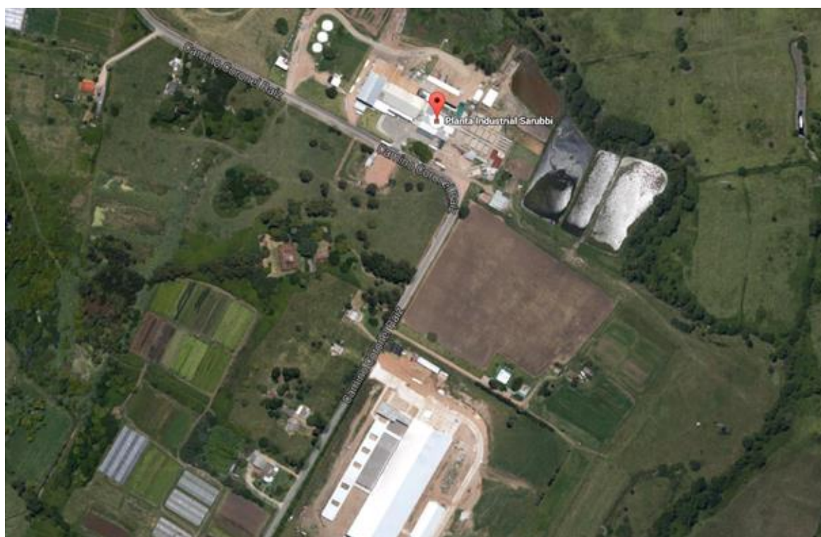
Imagen 2: Vista aérea de la planta de producción
