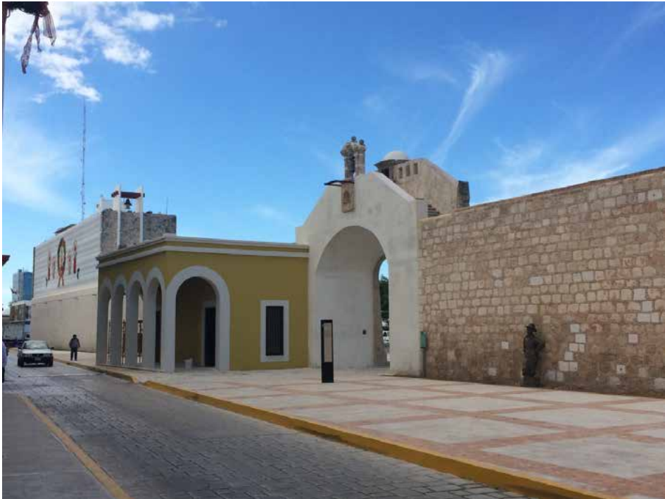
Figura 5. Calle 8 con reedificaciones de diferentes épocas: Puerta de Mar (1957), primer lienzo de muralla (1995), segundo lienzo y cuerpo de guardia (2014). Foto: Aída Casanova, 2014
