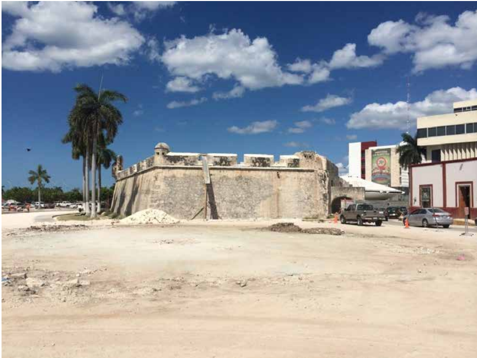
Figura 6. Reconstrucción de la muralla, tramo Circuito Baluartes, para lo cual se demolieron una fuente y un parque, y se modificó la vialidad. Foto: Aída Casanova, 2014
