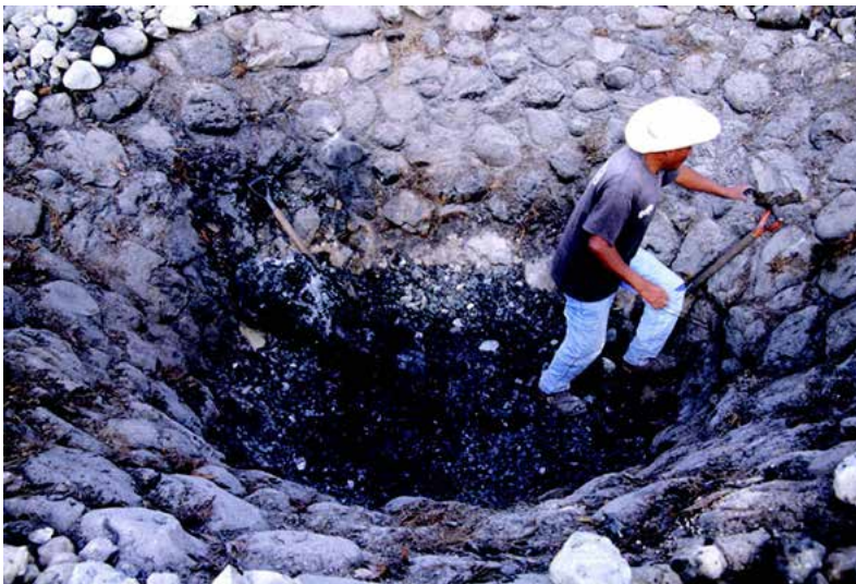
Figura 5. En la comunidad de Santiago Matatlán, Oaxaca, México se utilizan todavía diversos hornos de grandes dimensiones (3.50 m de diámetro) con paredes de piedra. Foto: Carlos Lazcano Arce, 1998
